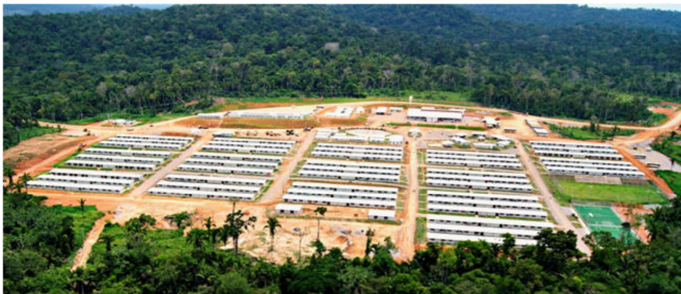
Arranjo geral do canteiro de obras que envolvem as áreas administrativas, os alojamentos e os ambientes de recreação.
