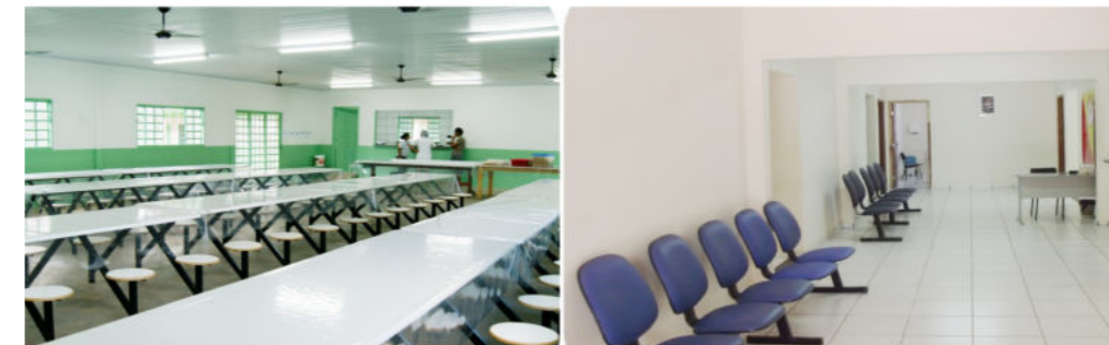
Reforma e ampliação de 11 escolas municipais
