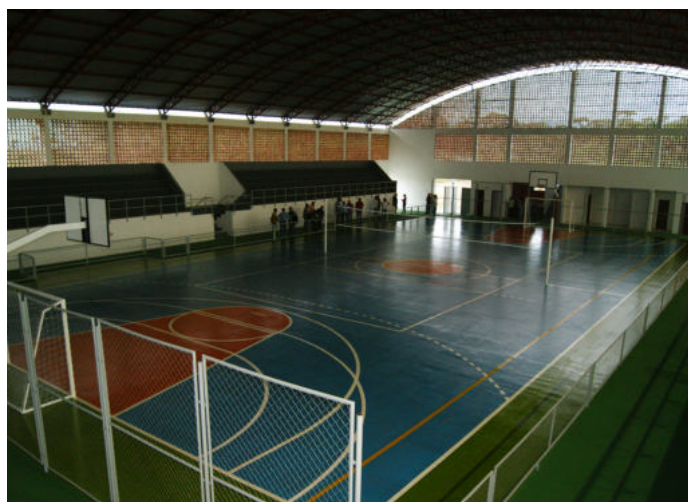
Ginásio tem capacidade para 1.200 pessoas
