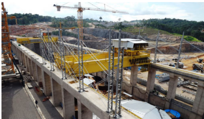
A cobertura metálica da Casa de Força pesa em média 300 toneladas e resiste as mudanças climáticas
