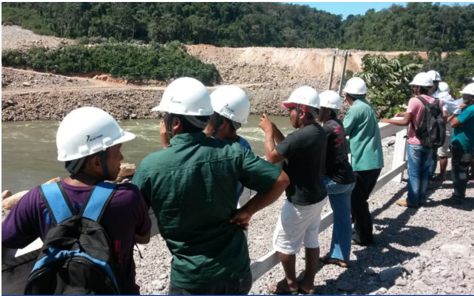
Cerca de 22 indígenas conhecem o andamento e as estruturas da obra
