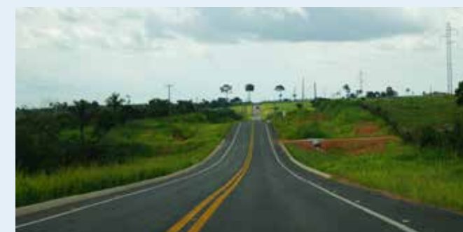
Rodovia recebeu 38 km de pavimentação
