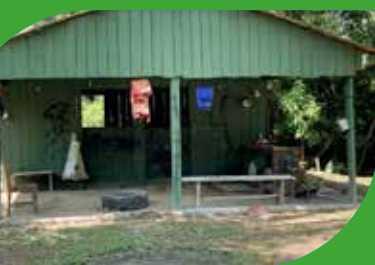
Estrutura e acesso irregulares em APP
