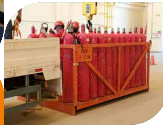
Sinalização com orientação de segurança em escadas (esquerda) e manutenção dos equipamentos de combate a incêndio do sistema fixo das Unidades Geradoras (direita)
