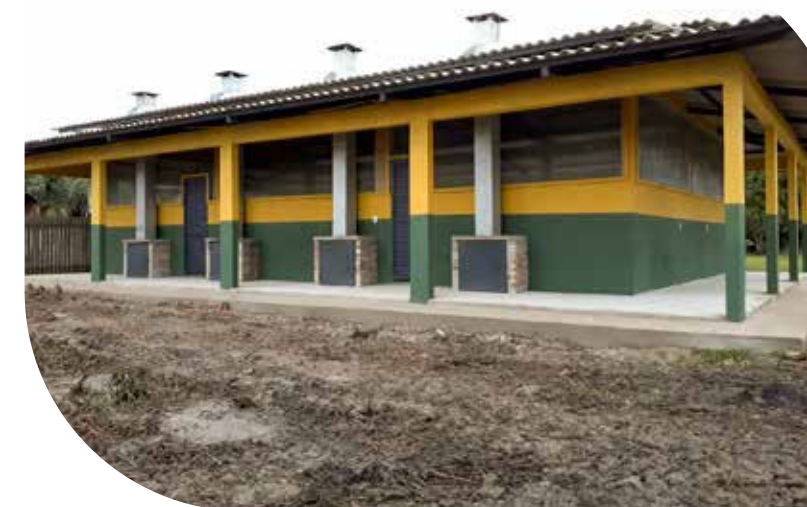
Casa de Farinha da Aldeia Papagaio foi concluída e entregue em fevereiro de 2022
