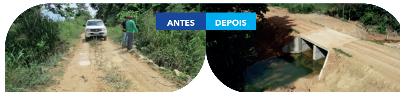
Ponte 4 antes e depois das obras
