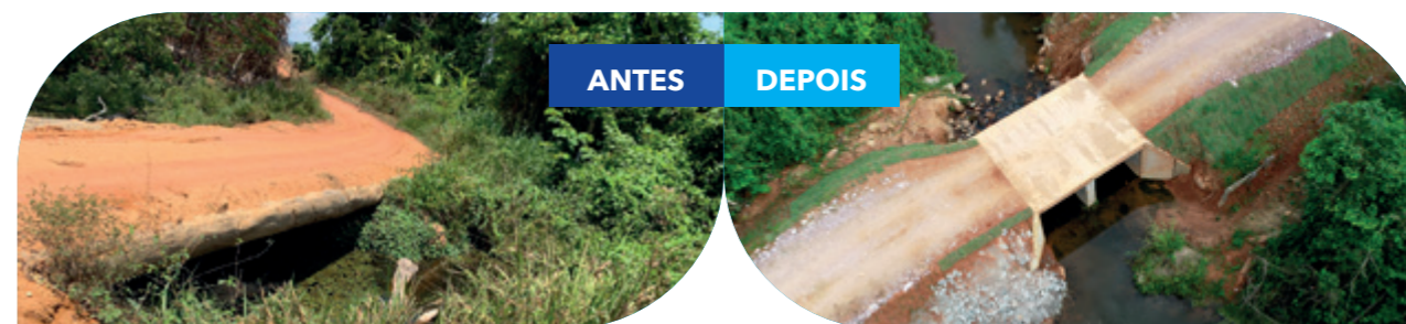
Ponte 3 antes e depois das obras
