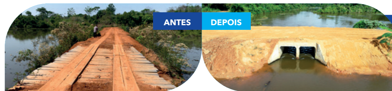
Ponte do Porcão antes e depois das obras
