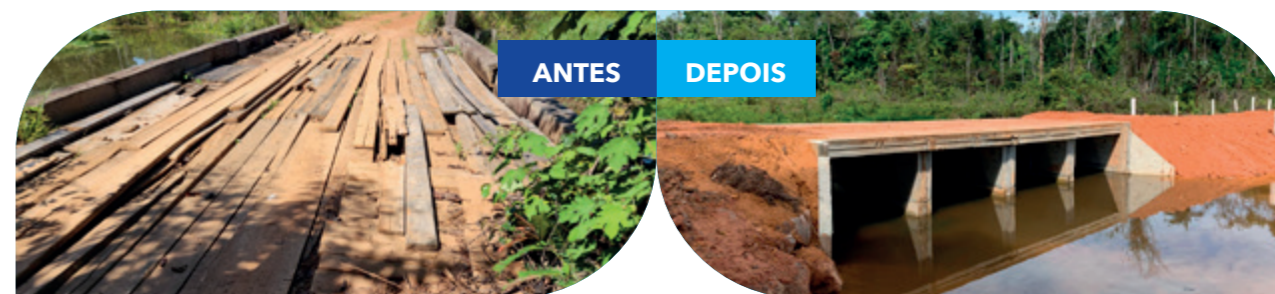
Ponte 2 antes e depois das obras
