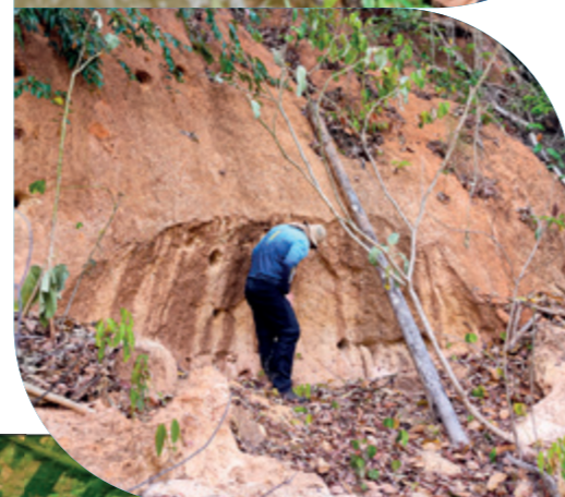
Equipe técnica avalia os trechos indicados com processos erosivos.
