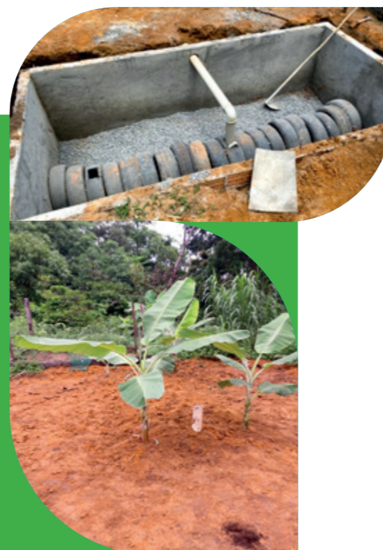
Construção de fossa ecológica na comunidade Rio Jordão
