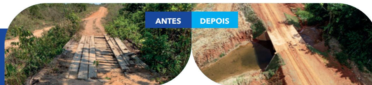
Ponte 6 antes e depois das obras
