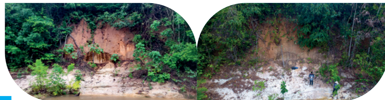
Erosão no trecho ME-27 em novembro de 2021 (à esquerda) e vistoriado por técnicos em agosto de 2022 (à direita)
