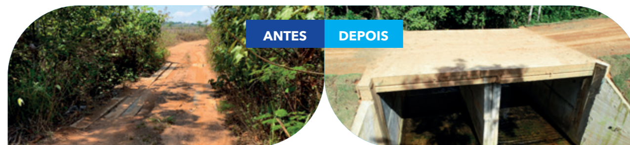
Ponte 5 antes e depois das obras
