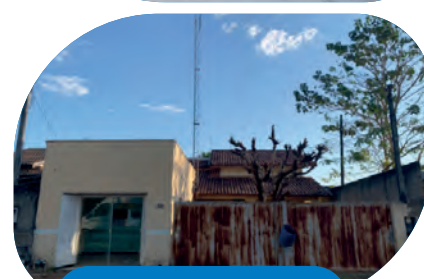
Fachada da Casa de Apoio e Escritório Apiaká antes e depois
