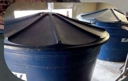
Reservatório da casa de força
